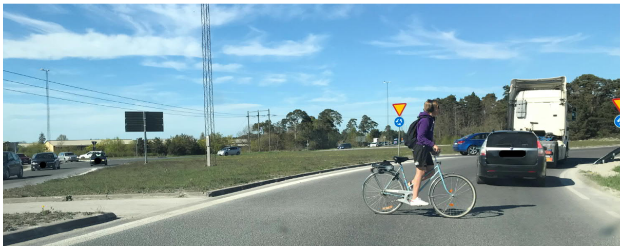
Figur 15. Passage tvärs Visbyleden vid väg 147 (cpl Follingsborondellen). Cyklande måste korsa två körfält i en etapp.
