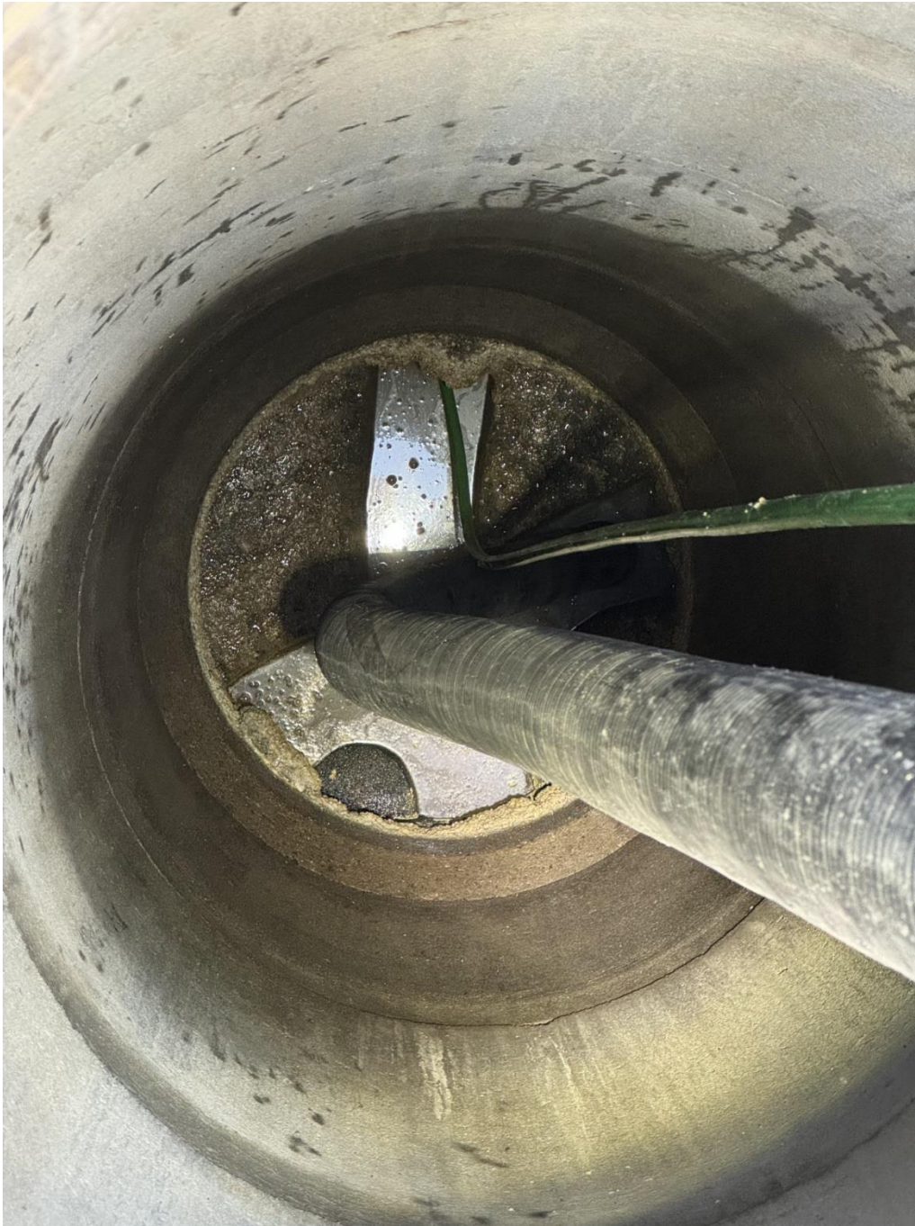
Botten av SNB 1095. Nivån har sänkts så att vi ser hur ledningarna ansluter till brunnen. Spolslangen (1/2") är instucken en bit in i en av de anslutande ledningarna.
