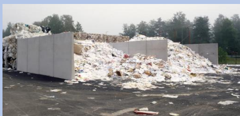
Bild; fickor som ska fungera som stödmur, finns flera olika varianter. Uppdragets hantering har behov av 5 fickor.
