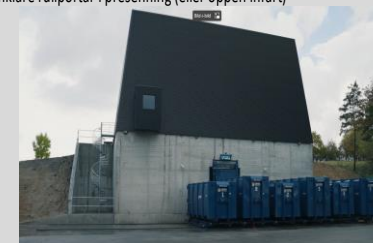
Bild; I detta utförande kan tre bilar lossa samtidigt. Dessutom kan de lossa tre olika avfalls slag samtidigt. Operatören väljer fram rätt container och styr avfallet till avsedd container. https://www.youtube.com/watch?v=rMW0Tk4lPI
