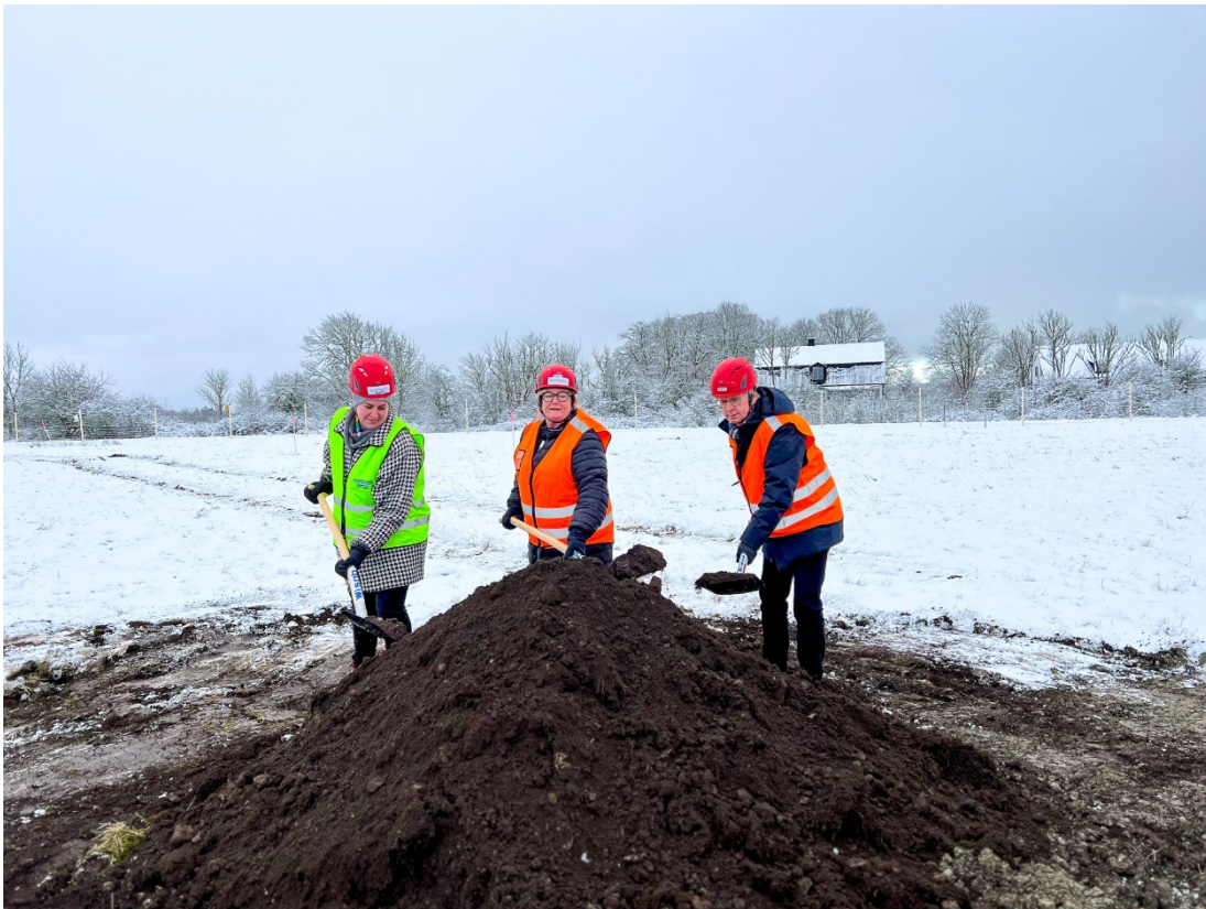
Första spadtaget i Klintehamn januari 2024.
