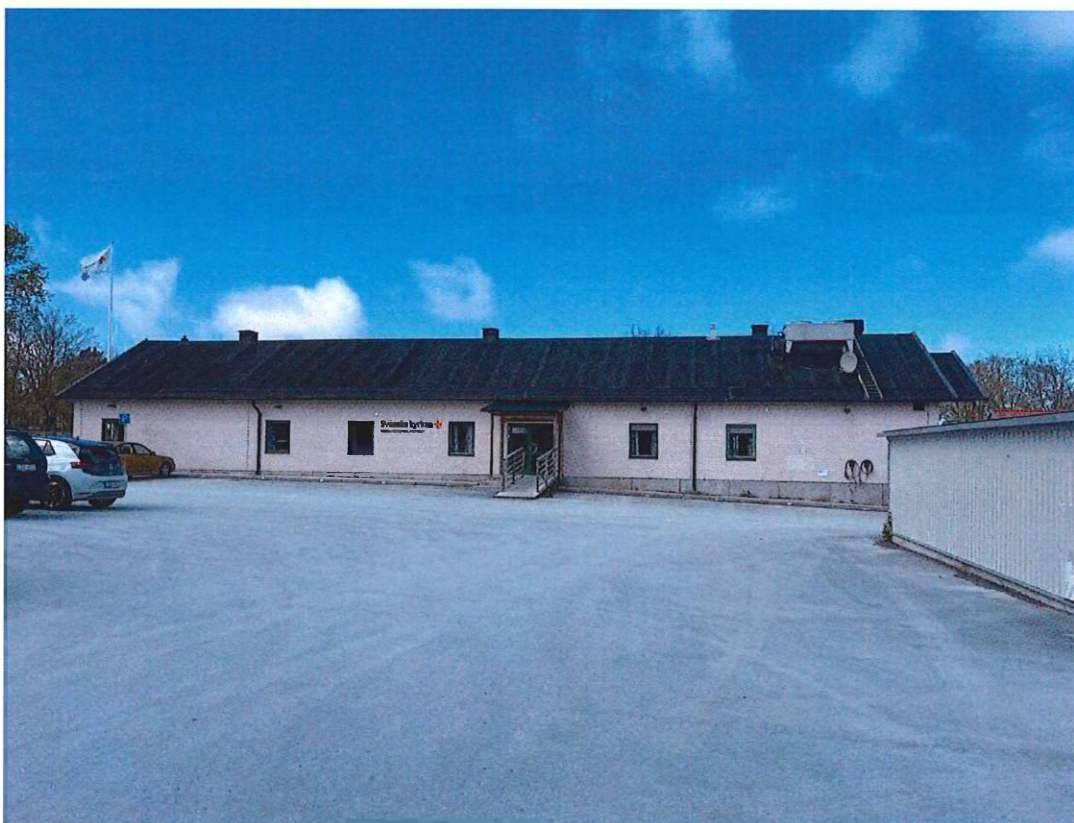
Bild på befintlig verksamhetsbyggnad och parkering inom fastigheten.
