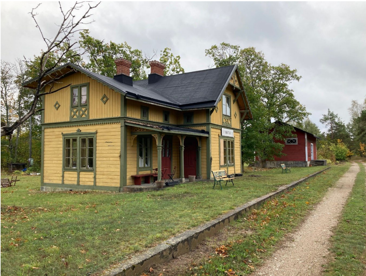
Figur XX. Den före detta stationsmiljön i Buttle med välbevarat stationshus och godsmagasin, perrong och banvall. Även stationsmiljöns alla uthus finns bevarade. Foto: Länsstyrelsen 2024.
