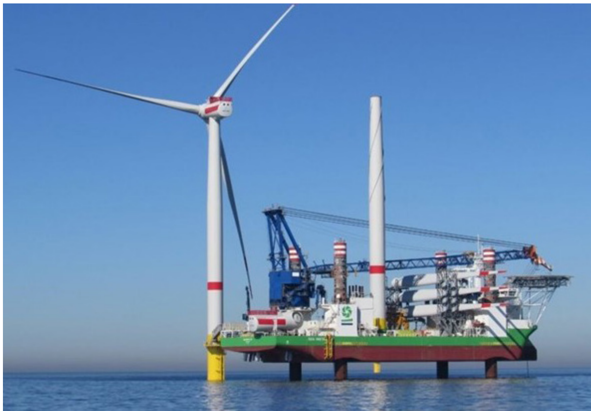
Figur 28. Montering av vindkraftverk med ett fartyg av typen jack-up. Källa: COWI.
