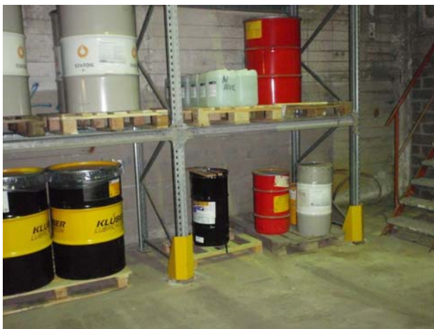
Foto: Oljeförråd vid Cementverk 7-8, inomhus utan golvbrunnar
