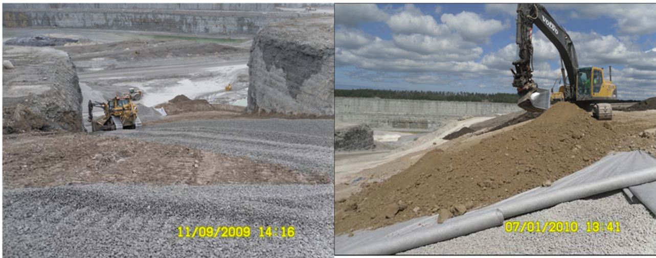
Figur 3: Utläggning dräneringsgrus (vänstra bilden) samt geotextil och skyddstäckning (högra bilden) vid avslutning av den västra deponin i Västra brottet.
