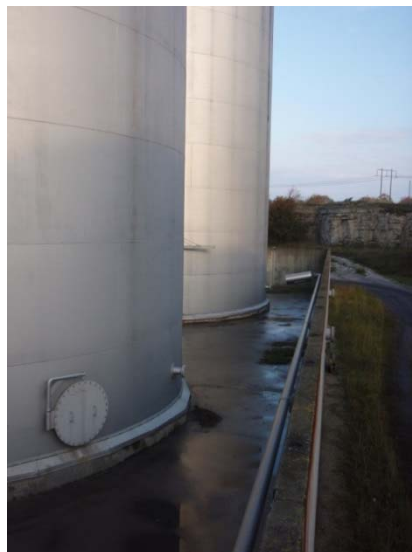
Foto: Lännaberget, cisternerna 8-9, betongmur
