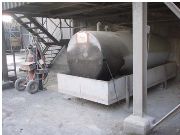
Foto: Förvaring diesel, söder om den mekaniska verkstaden
