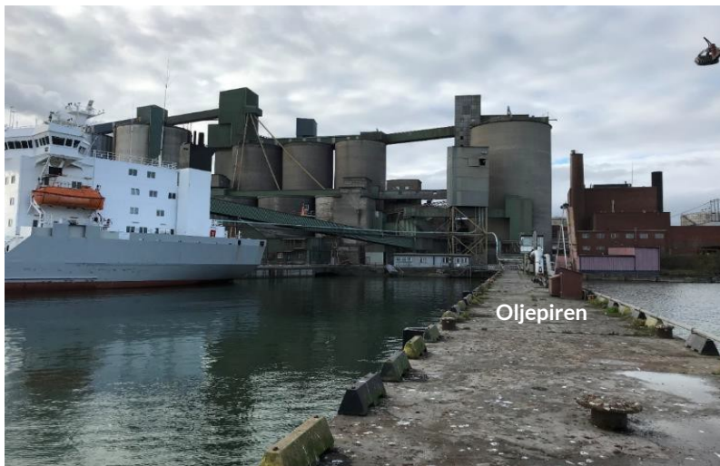
Figur 2.3 Oljepiren med rörinstallationer [Foto taget 2022-11-10]. Källa okänd
