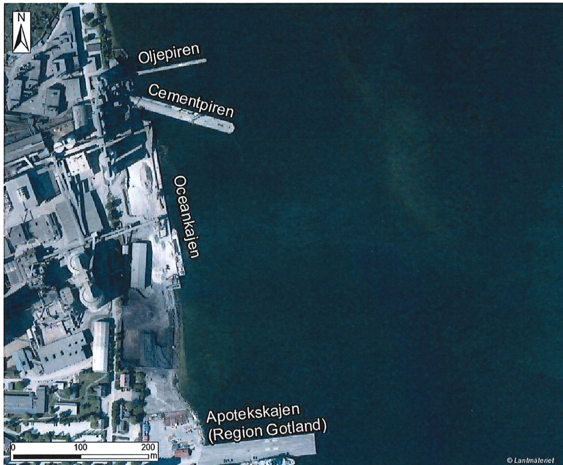
Figur 2-2 Befintliga pirar och kaj inom verksamhetsområdet.
