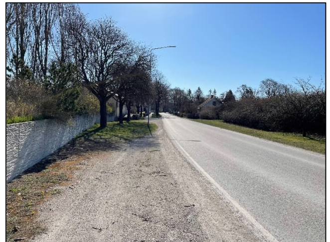
Figur 31: Gångbana längs Skolgatan upphör väster om Heidelberg Materials kontorsbyggnad.
