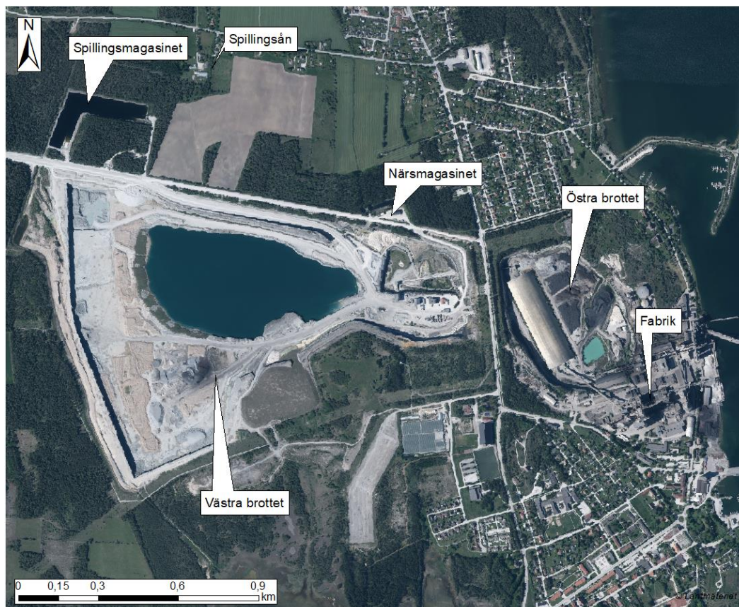
Figur 6.7. Spillingsmagasinet, Västra brottet med mera.
