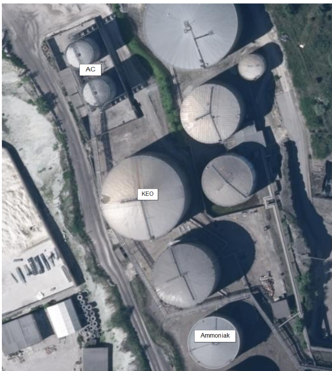
Figur 21. Heidelberg Materials cisterner på oljeberget med innehåll. Cisternraden till höger tillhör GEAB och är inte del av ansökt verksamhet.
