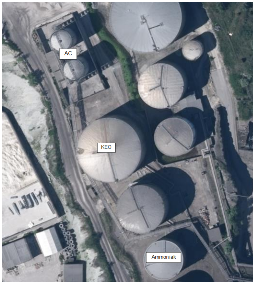
Figur 13. Cisterner på oljeberget. Cisternraden till höger tillhör GEAB och är inte del av ansökt verksamhet.
