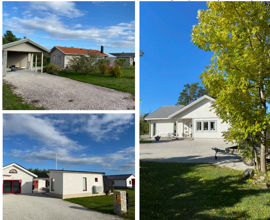
Figur. Fotografier övre befintligt område.
