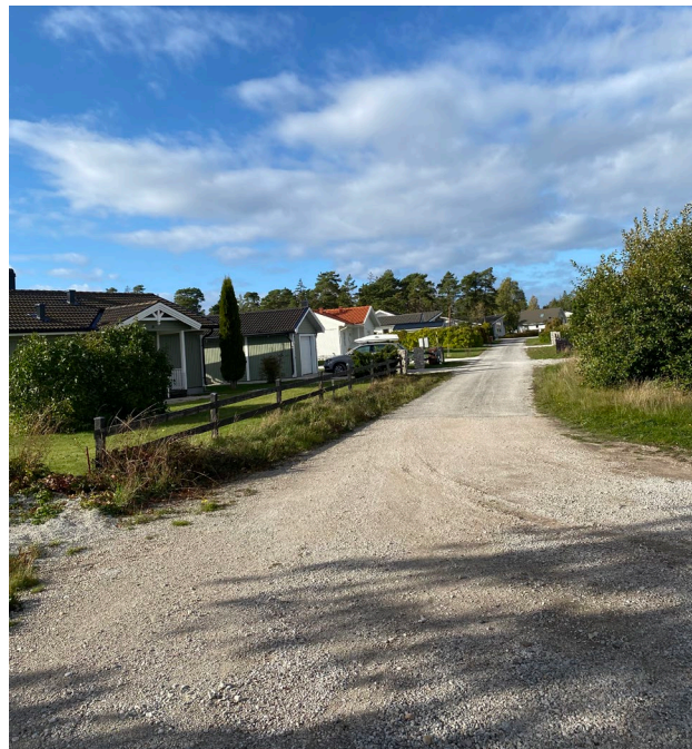
Figur. Foto över befintlig vändplats vid Vindilevägen.
