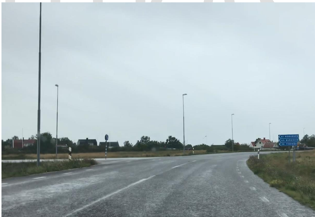
Figur 15. Väg 141 i riktning mot Klintehamn vid korsning med anslutande väg 140 söderut.
