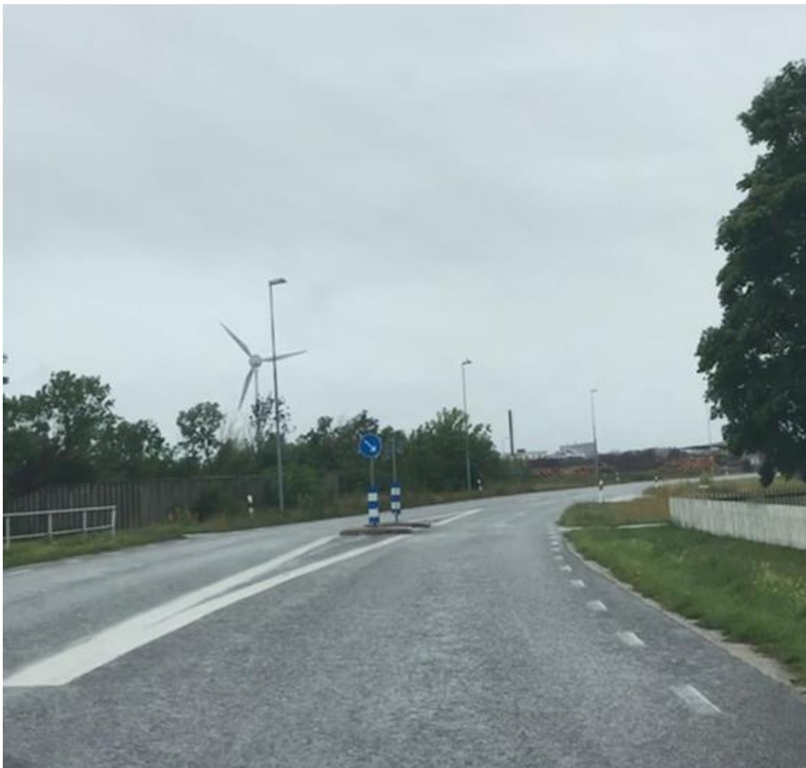
Figur 11. Väg 140 i riktning mot Klintehamn. I fotot syns den gång- och cykelpassage över väg 140 som finns utmed sträckan.
