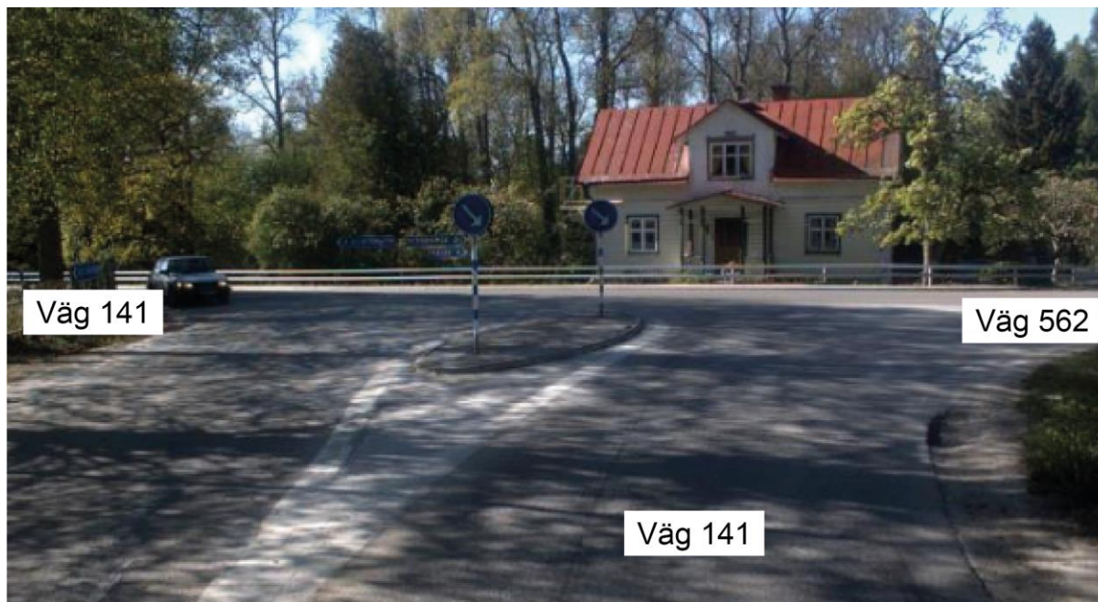
Figur 18. Korsning vid Bönners backe. Refugen är nu borttagen. Fotot är taget från väg 141 söderifrån. Bildkälla: Trafikverkets verktyg PMS.
