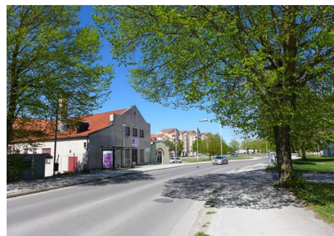
Elektricitetsverksbyggnaden till vänster i bild. Foto taget från Stenkumlaväg mot Söderrondellen.
