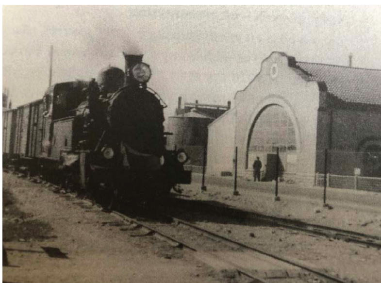
Järnvägsspår öster om Stenkumlaväg. Visby Elektricitetsverk kan ses till höger i bild. Källa: Föreningen Gotlandstågets samlingar.
