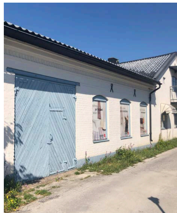
På fasaden syns ankarjärn och profileringar mot takfot. Den blå träporten är ett karaktäristiskt inslag.
