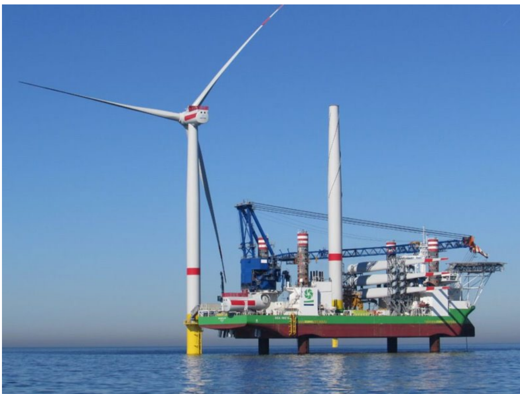
Figur 20. Montering av vindkraftverk med ett fartyg av typen jack-up. Källa: COWI.
