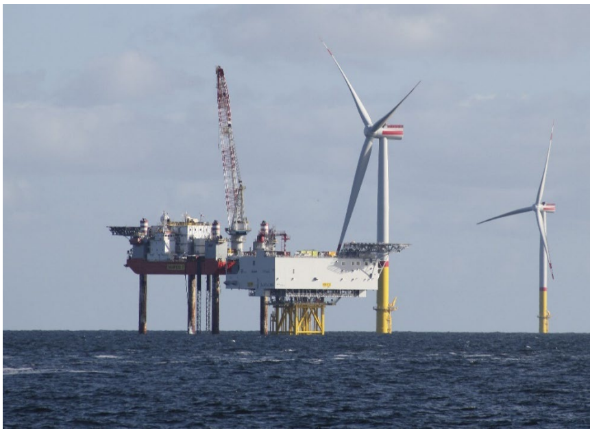
Figur 22. Stödbensfartyg (jack-up) vid en transformatorstation som är grundlagd på en fackverkskonstruktion.
