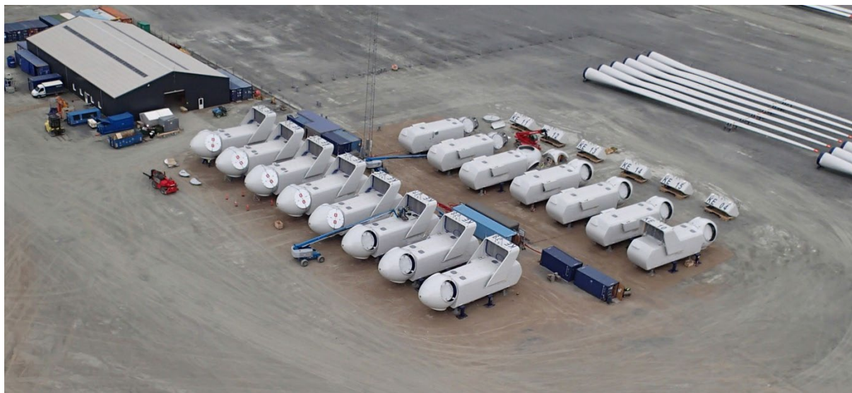
Figur 19. Maskinhus och rotorblad som vid slutmonteringshamnen färdigställs för installation. Foto: Göran Loman.
