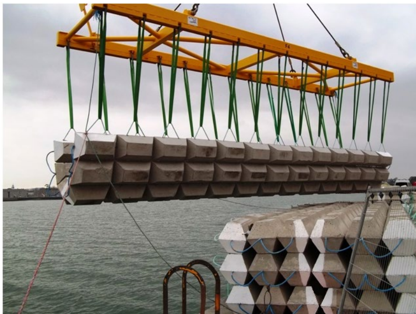
Figur 27. Exempel på betongmadrass som används som kabelskydd. Källa: Subsea Protection Systems.
