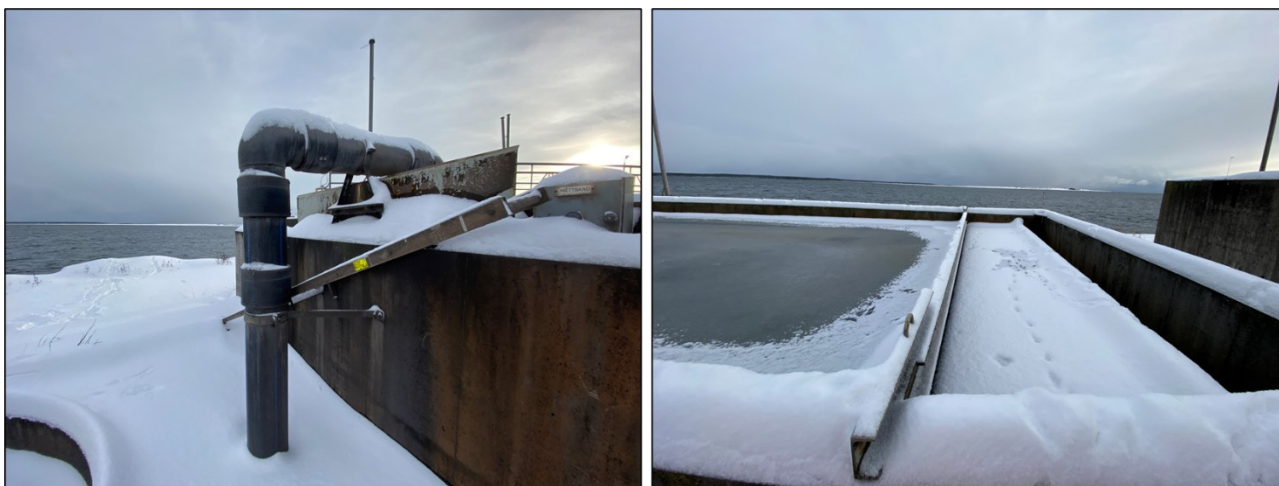
Figur 12 Sedimenteringsbassängen. Bild: WSP/Per Norberg, 2023.
