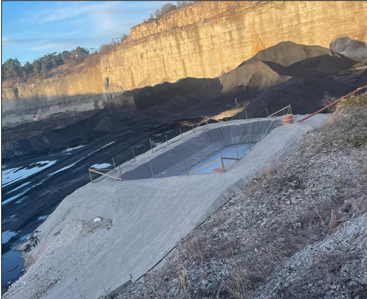
Figur 17-3 Släckvattendamm i Östra brottet.
