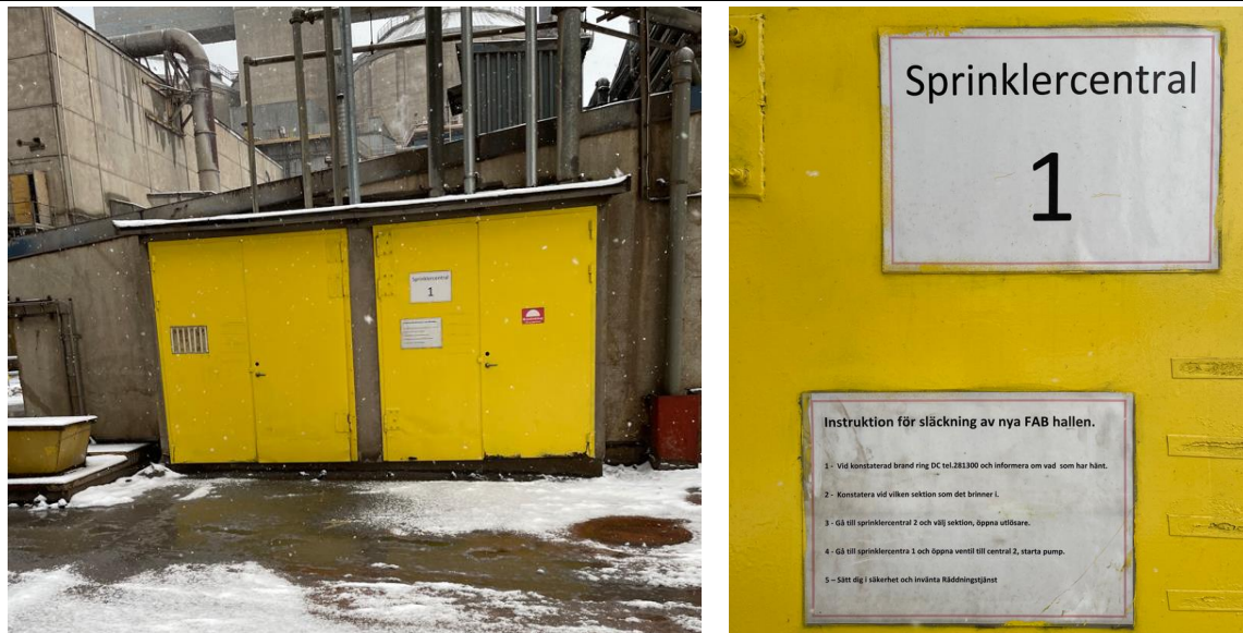
Figur 17-1 Aktivering av sprinkler för FAB-hallar.
