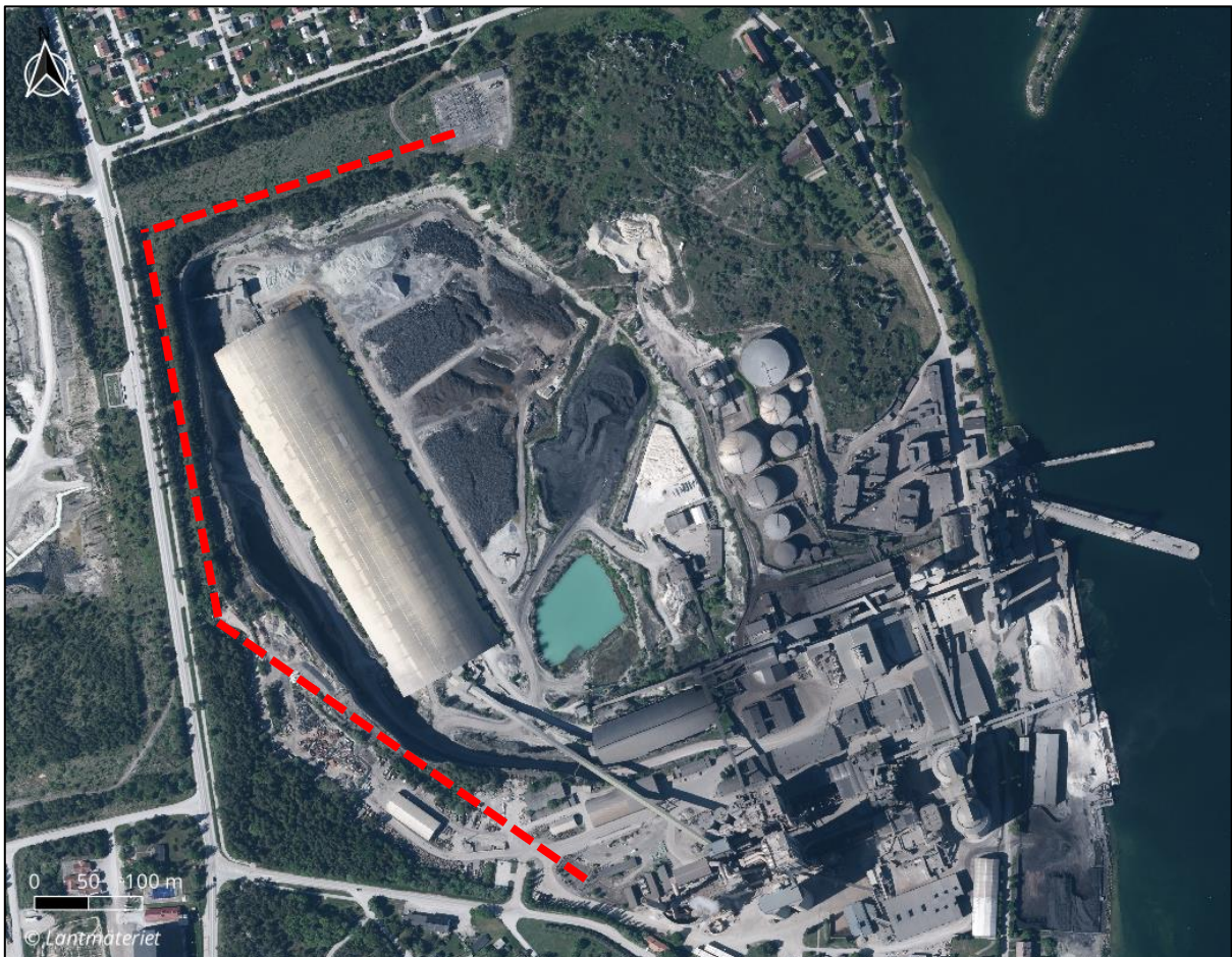
Figur 12-8 Befintlig matning till verksamheten från GEAB:s ställverk på Länna-
