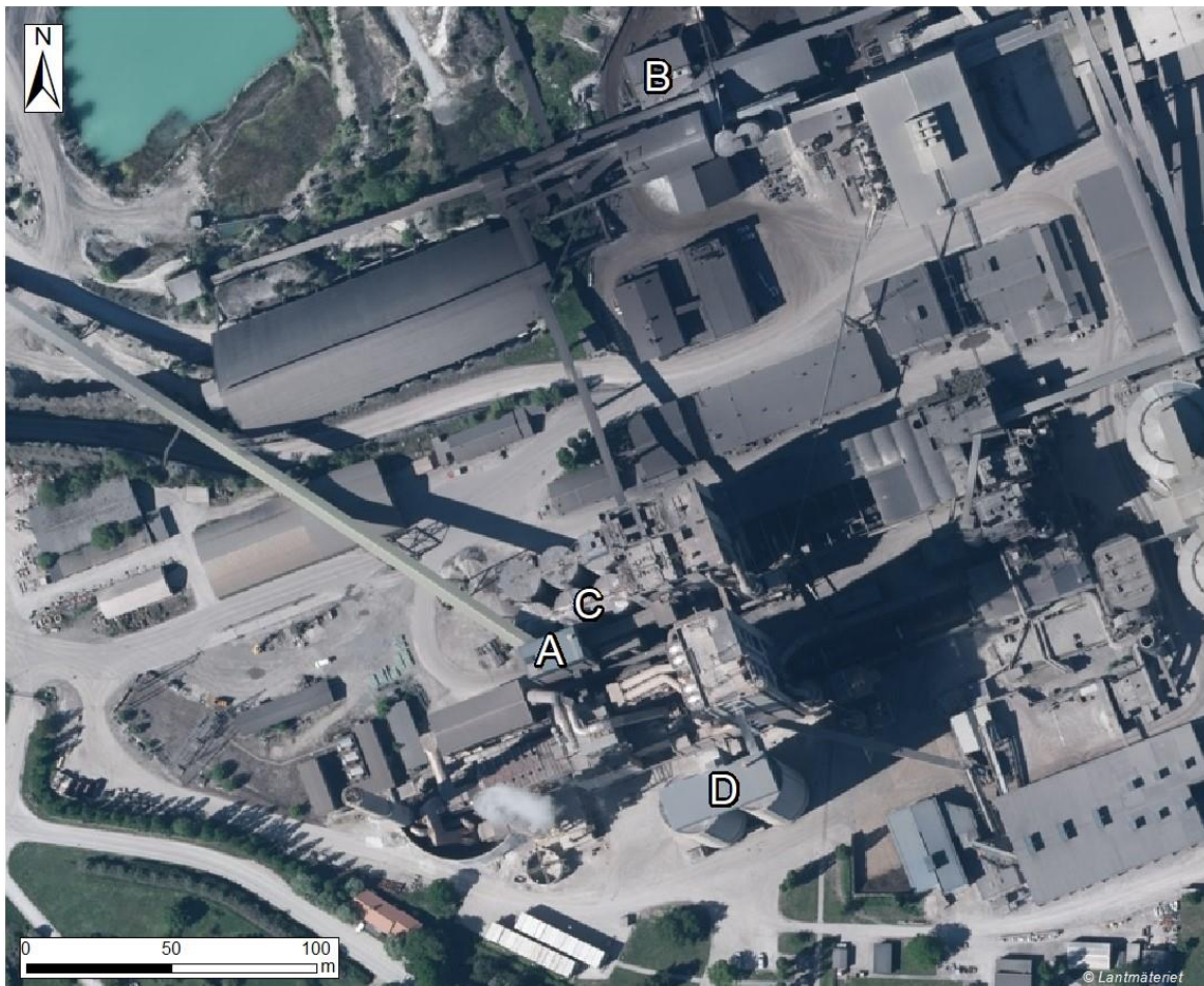
Figur 4-2 Stenfördelningstorn, slamkvarnar och råmjölssilor.
