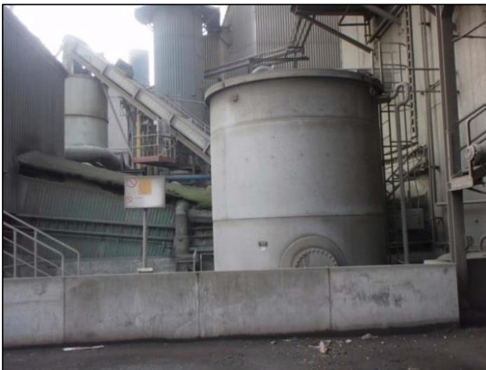
Figur 12-7 Invallning eldningsolja 1 (Eo1).
