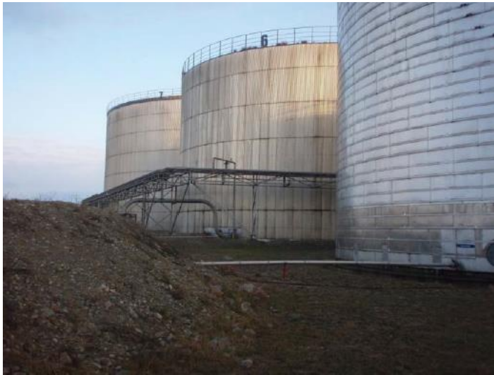
Figur 12-5 Invallning av kemicaliecisterner för KEO och ammoniak (konc. <25%-).
