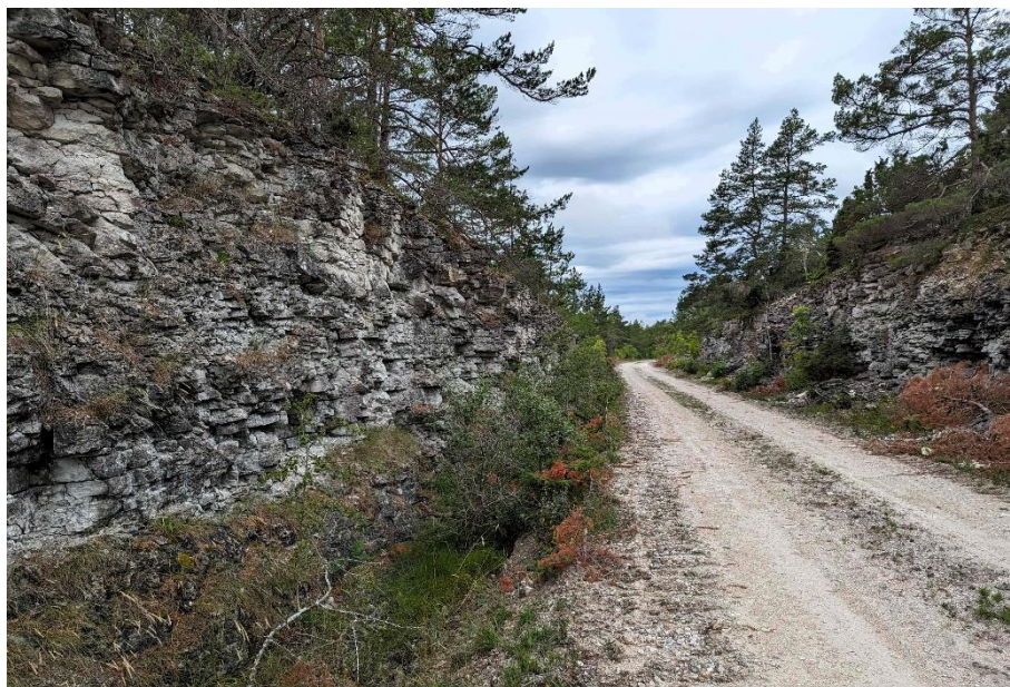
Foto 1. Fotot visar hur diket ser ut vid dikessträcka 1. Det är taget från öster till väster. I bilden syns även vägen, de bergbranter som omger vägen samt lite av de trädklädda miljöerna ovan branterna.
