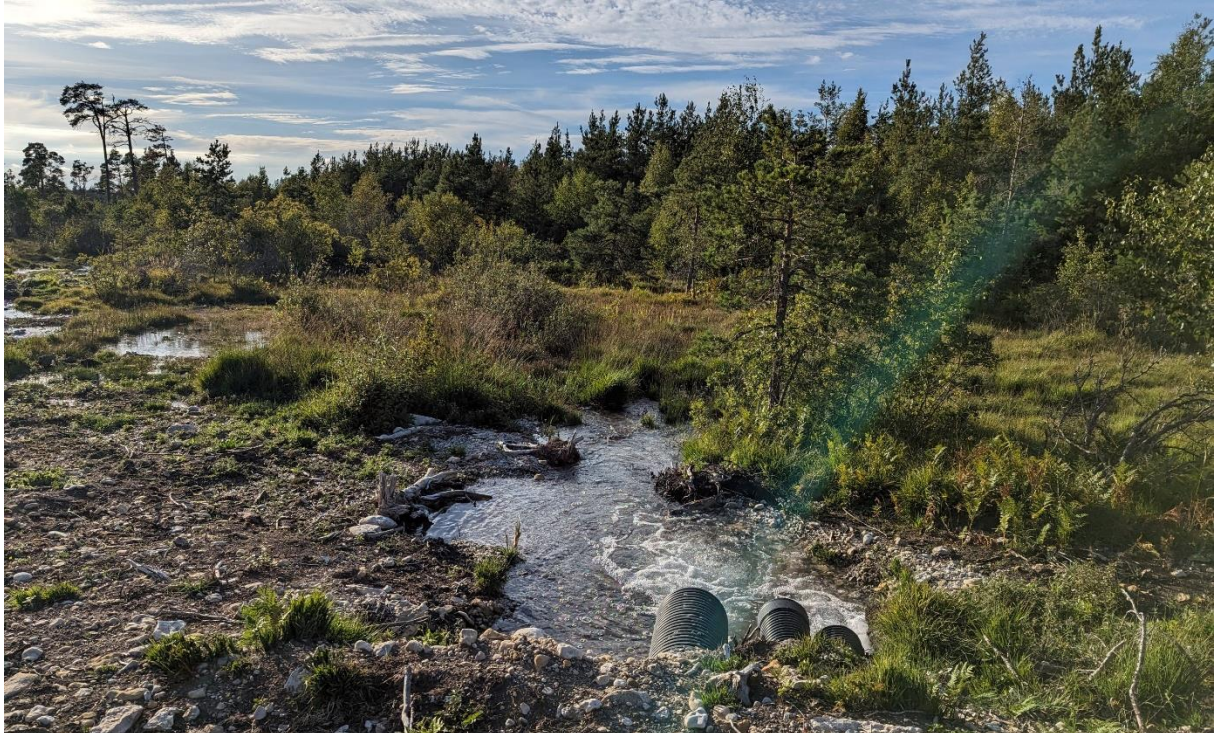
Fotot visar NVO 22a. I förgrunden syns de rör som det pumpade vattnet kommer ut från. T.v. i bild syns en del av den uppgrävda korridoren.
