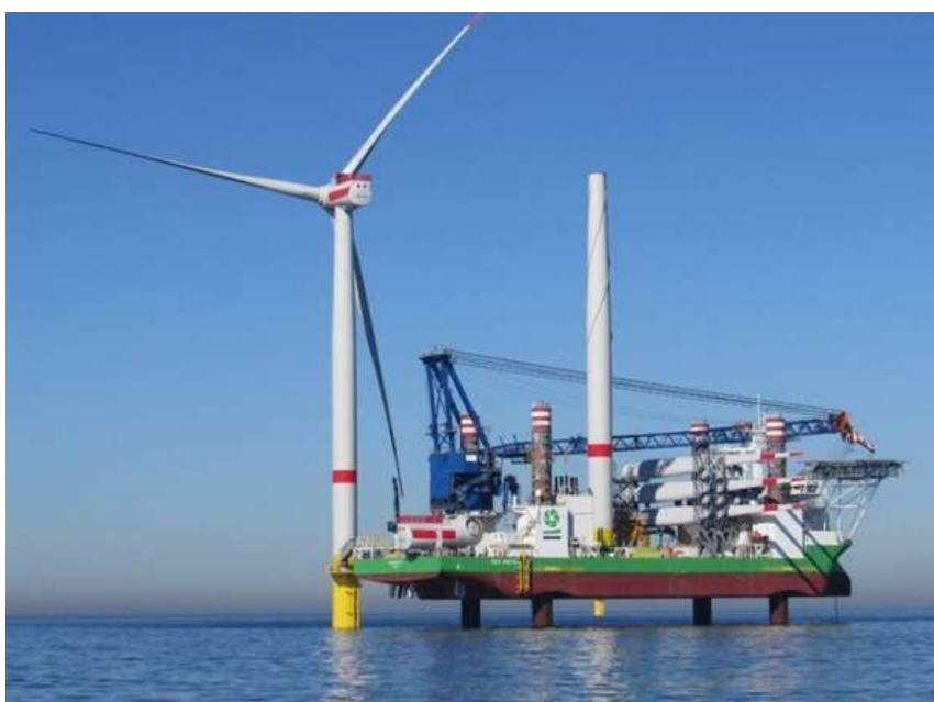
Figur 17. Montering av vindkraftverk med ett fartyg av typen jack-up. Källa: COWI
