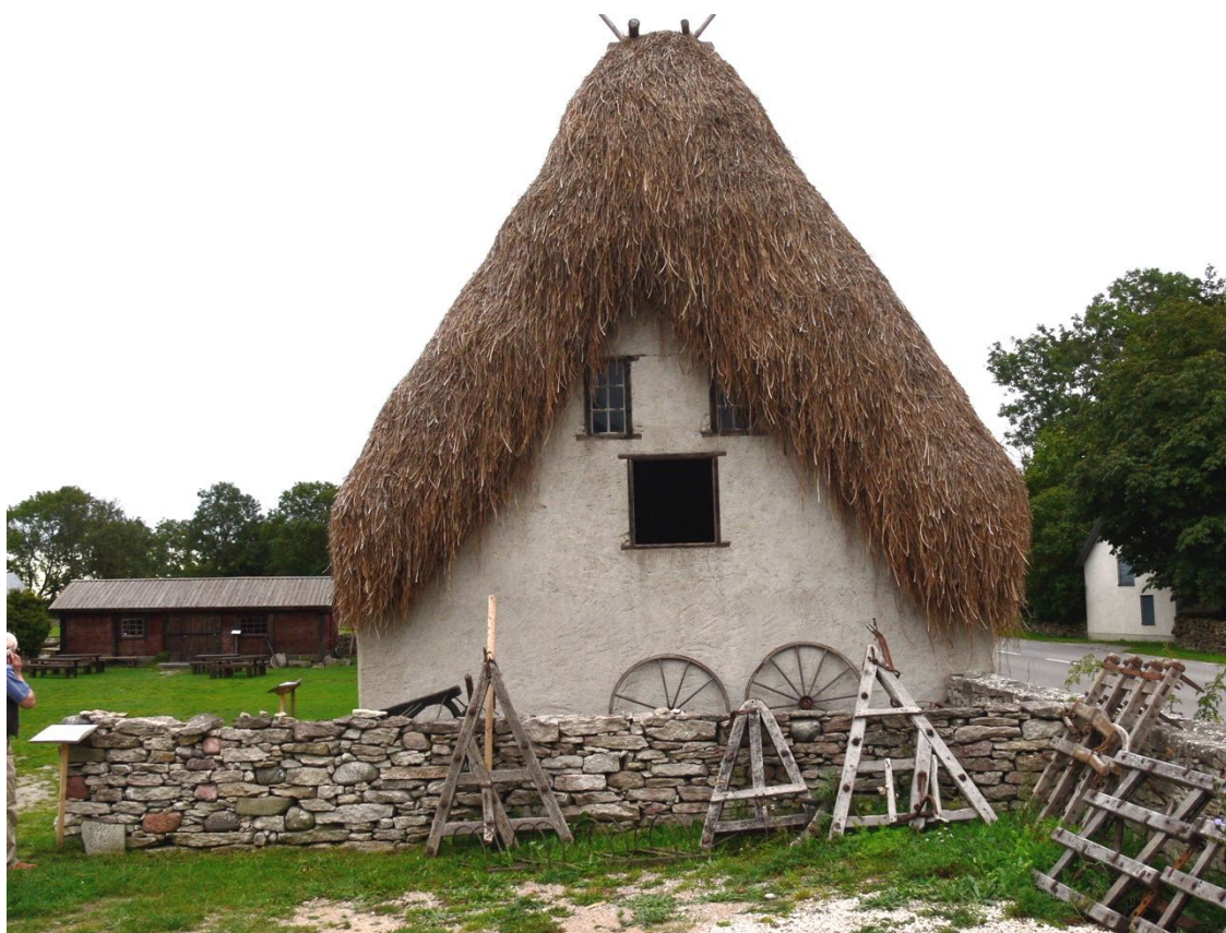
Figur 19. Bottarvegården med agtak. Revkalkstenen kan liknas vid traditionella gotländska agtak i att den tätande effekten fås av enormt många strån som ligger omlott med varandra. På samma sätt ligger det i revkalkstenen årmiljoner av korallrev som utvecklats omlott kjämfört med underliggande rev. . Foto av Wolfgang Sauber - Eget arbete, CC BY-SA 3.0, https://commons.wikimedia.org/w/index.php?curid=3225720
