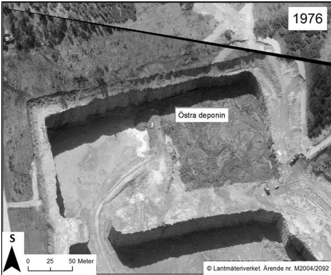
Figur 2 Flygbild över Östra deponin år 1976. Vy från norr. Observera luckan i berget genom vilken deponering skedde och som numera utgör nedan nämnda branta slänt, se kapitel 4.1 Geotekniska förhållanden.
