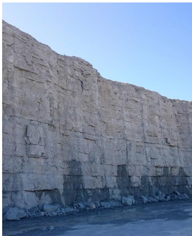
Figur 2-6 Figuren visar en bergvägg i File hajdar dagbrott. De subhorisontella lagren framgår tydligt som horisontala strukturer på bergväggen. De vattenförande lagren längs med bergväggens nedre del syns tydligt genom att vatten läcker ut från dessa lager.
