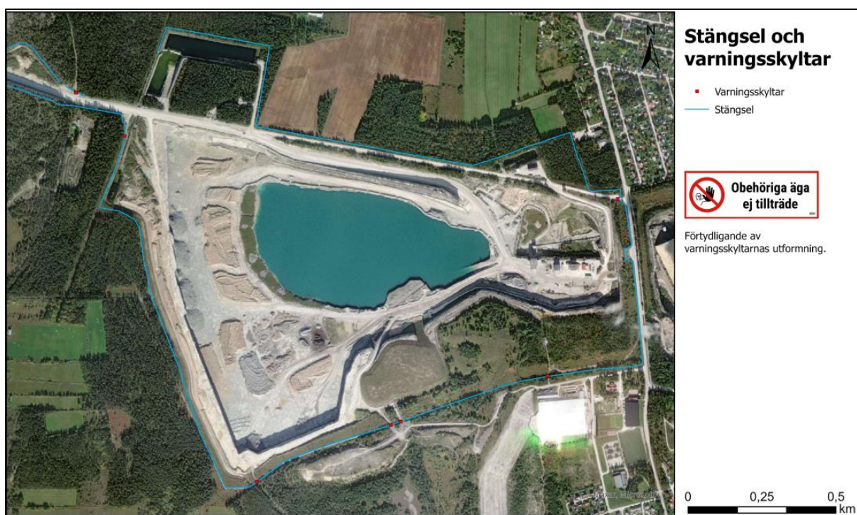
Figur 7. Stängsel och varningsskyltar varnar om riskerna med att beträda området runt Västra brottet och truckvägen. Stängsel visas med blå linje och varningsskyltar med röda punkter i kompletterande karta enligt föreläggande dnr. 555-442-2023 (2023-03-10).
