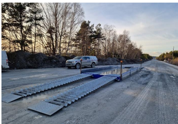
Figur 10. Hjultvätt strax före utfarten från Västra brottet (Foto: eget, 18 januari 2023).
