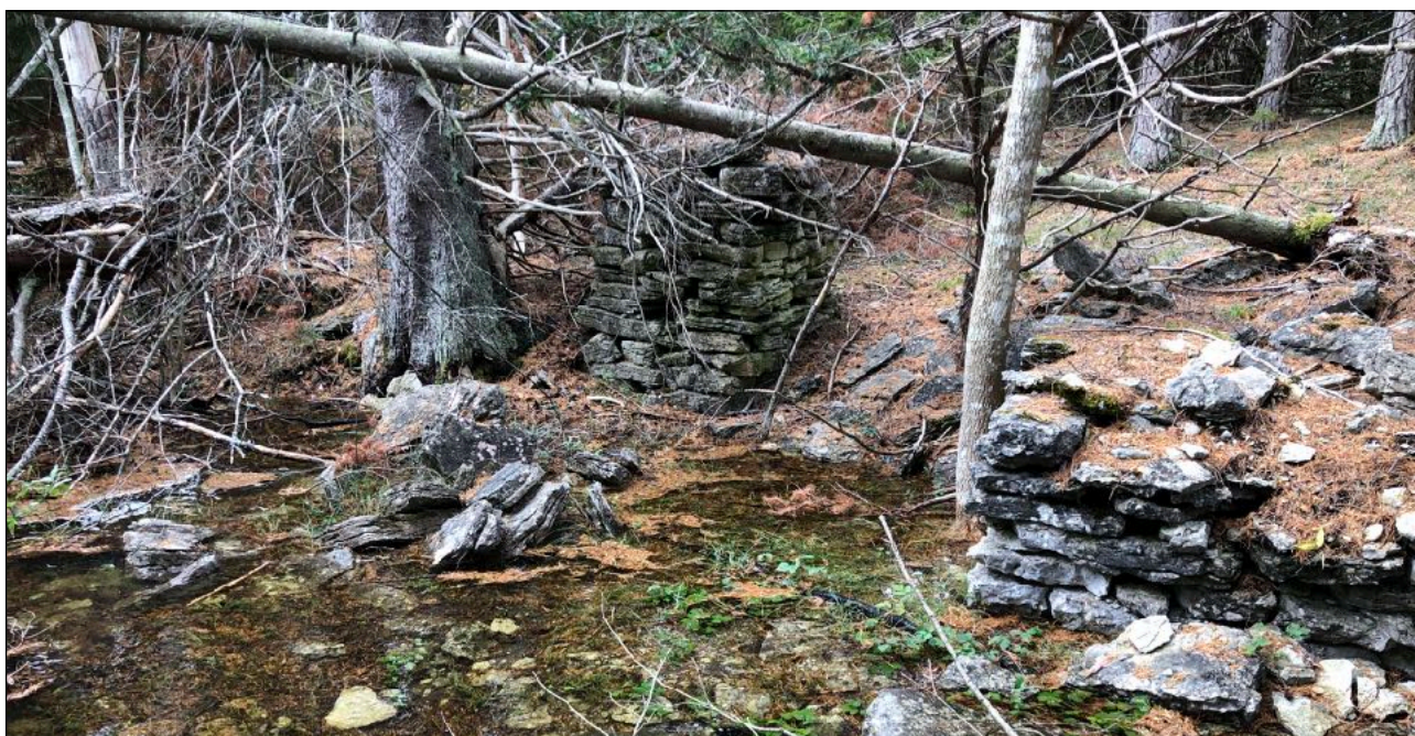
Figur 17. Den södra kvarnmiljön. Fundamenten till byggnaden, som varit inalles 6, kan ännu skönjas, där de som stått ute i vattnet dock är till stor del raserade. Bilden tagen mot väster, som tydligt visar att byggnaden stått på västra sidan av ån och att det rör sig om en såg i form av en hjulkvarn.
