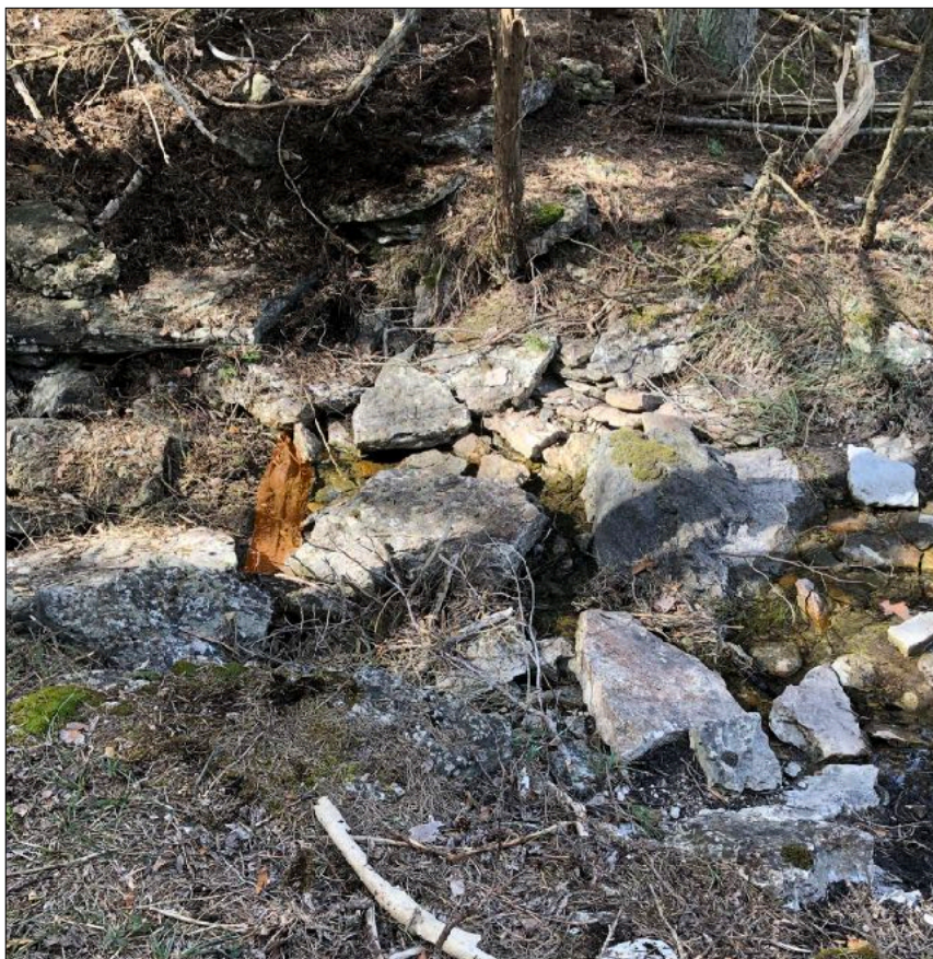
Figur 27. Bottenstocken för den ursprungliga dammluckan markerad med svagt brun ton. I bakgrunden syns den västra dammvallen bestående av uppstaplade kalkstenar. Förslaget till restaurering innebär att det nya dämnet anläggs något till höger i bilden för att inte påverka det äldre dämnet. Vattnet rinner från höger mot vänster.
