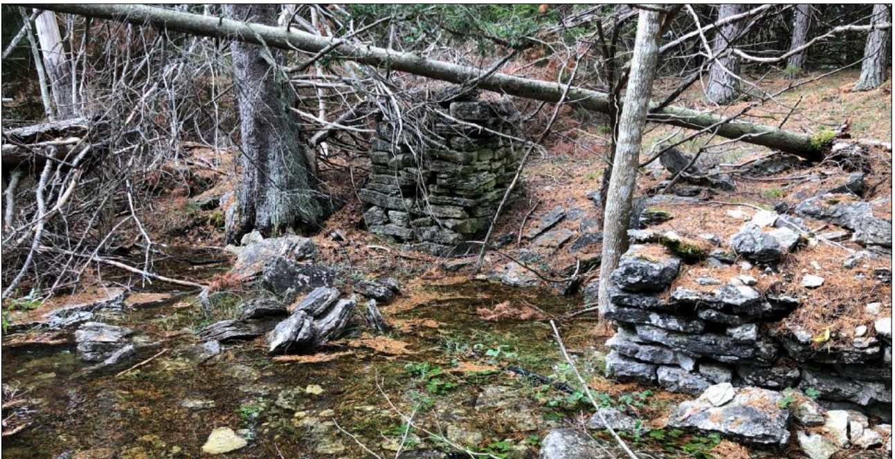
Figur 24. Resterna av sågkvarnen i form av kallmurade pelare som burit själva byggnaden.
