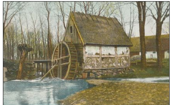
Figur 4. Hjulkvarn vid Stora Riseberga, Husie. Bilden visar en underfallskvarn, där vattnet träffar nedre delen av kvarnhjulet.
