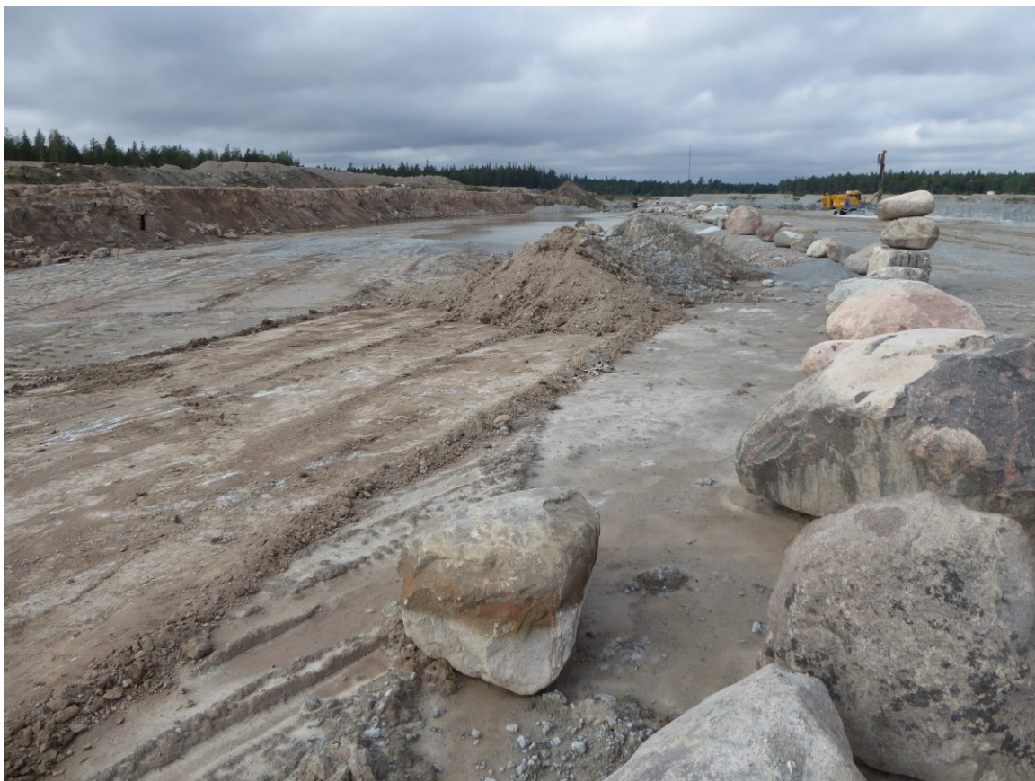
Figur 4.12. Det utökade täktområdet vid Västra brottet.
