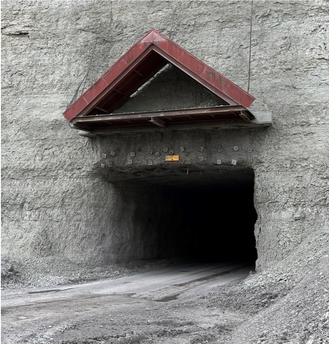
Figur 5 - Norra vägtunnelns påslag vid Östra brottet.
