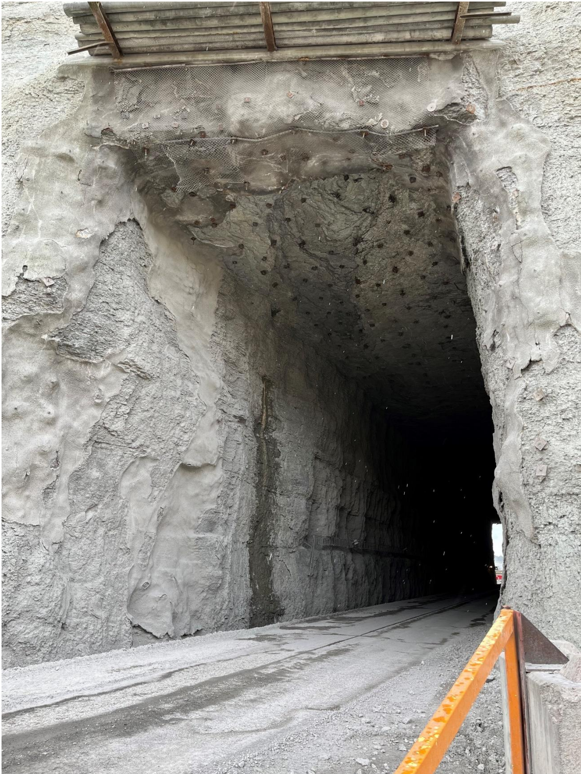
Figur 6 - Södra vägtunnelns östra mynning.
