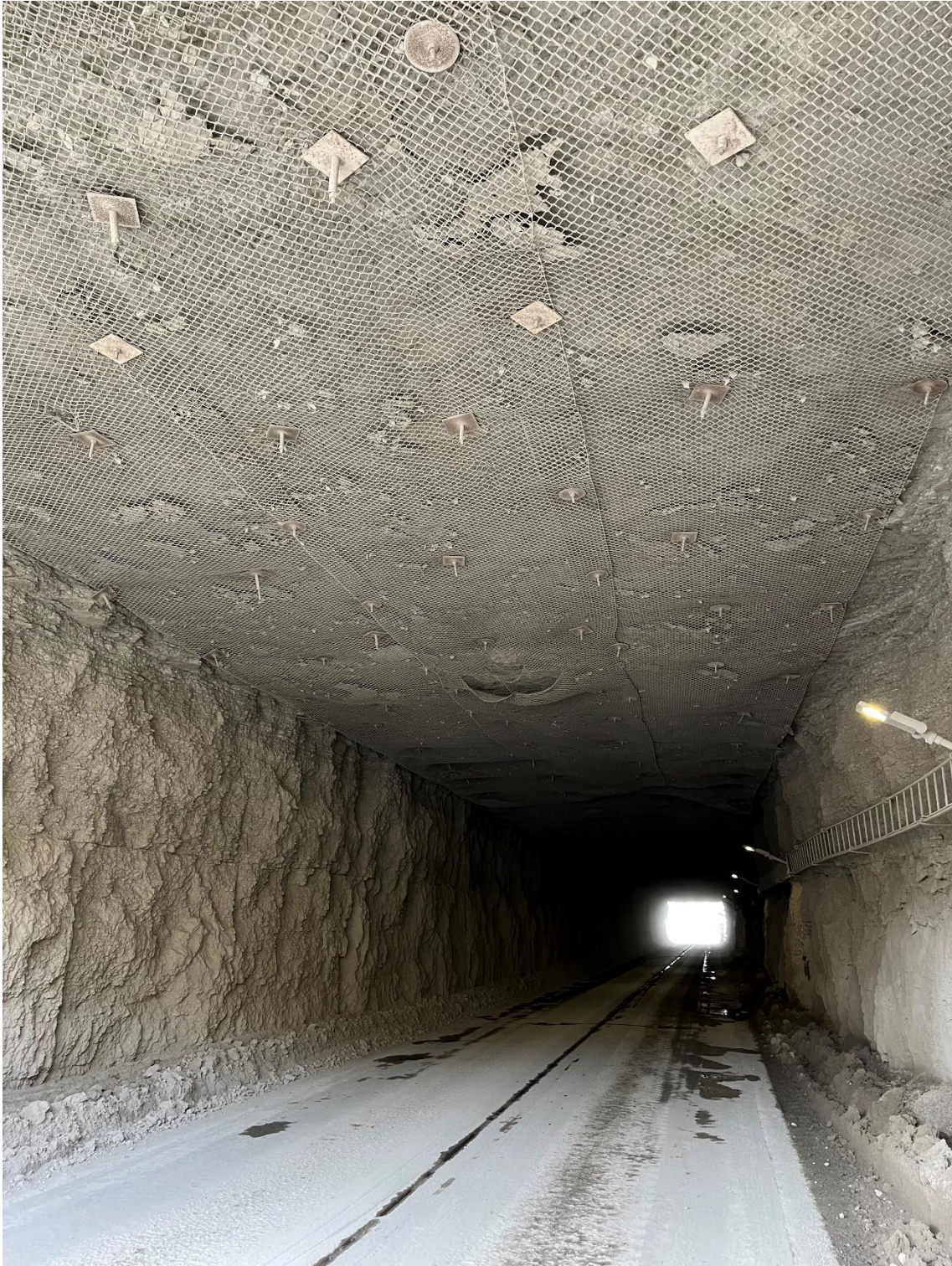
Figur 4 - Norra vägtunneln i riktning mot Västra brottet.
