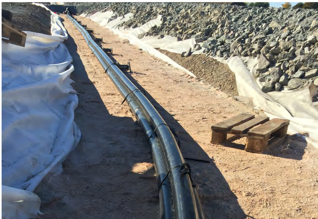
Figur 5.5. Kabelschakt med kablar i triangelformation.
