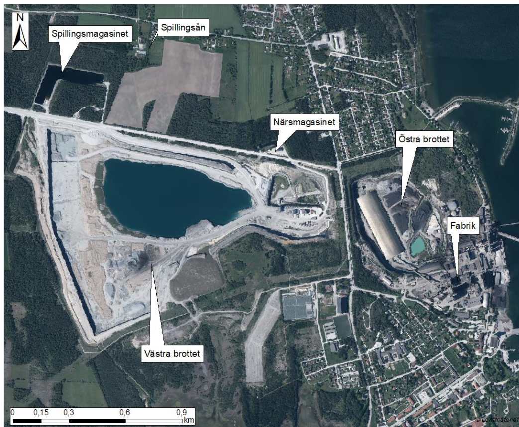
Figur 6.7. Spillingsmagasinet, Västra brottet med mera.
