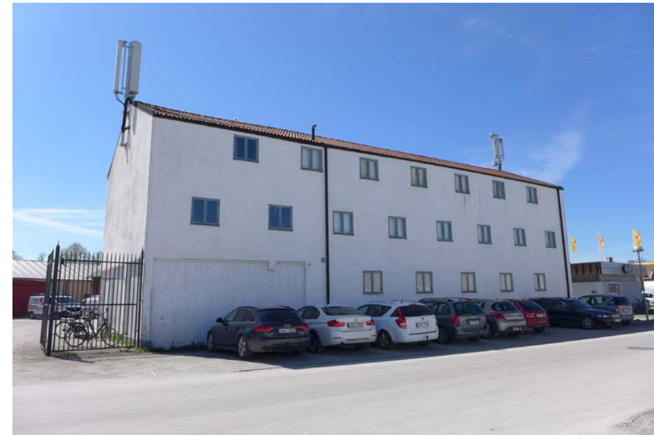
Fasad mot Gotenhofsgatan. Den tillbyggda lastbryggan är idag igensatt med en tillfällig träpanel.
