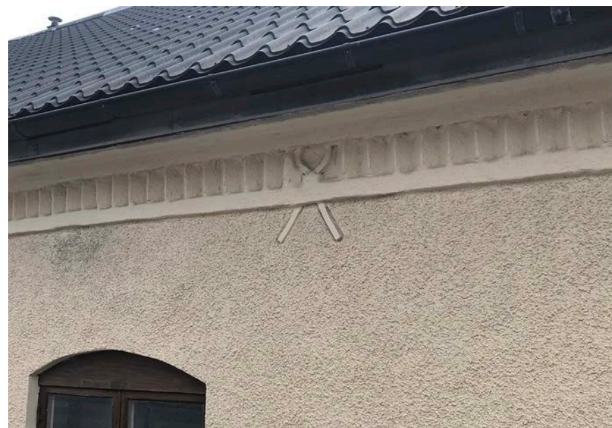
Ursprungliga detaljer med profilerad takfot och ankarjärn.
