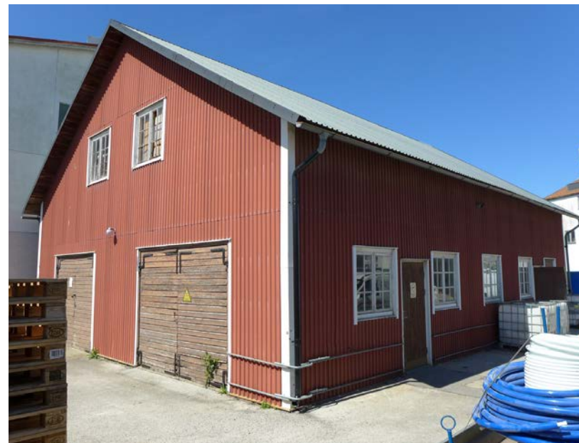
Verkstadsbyggnaden har äldre dubbelportar och fönster.
