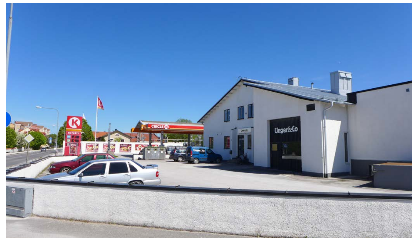
Den gamla gasverksbyggnaden är kraftigt ombyggd men är avläsbar i sitt fotavtryck och ytterväggarnas utformning. Den öppna ytan mellan byggnaden och Söderväg vittnar om det forna gasverksområdets utformning.
