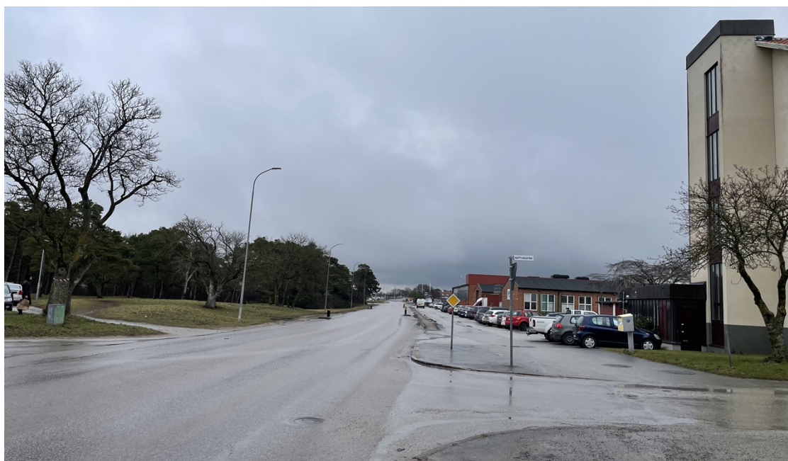
Broväg idag. Torslunden syns till vänster i bild. Broväg saknar ytor för gående och cyklister. Farthinder har fått ställas fram då trafiken kör snabbt. Delar av den allmänna gatan annekteras idag av intilliggande verksamheter för parkering.
