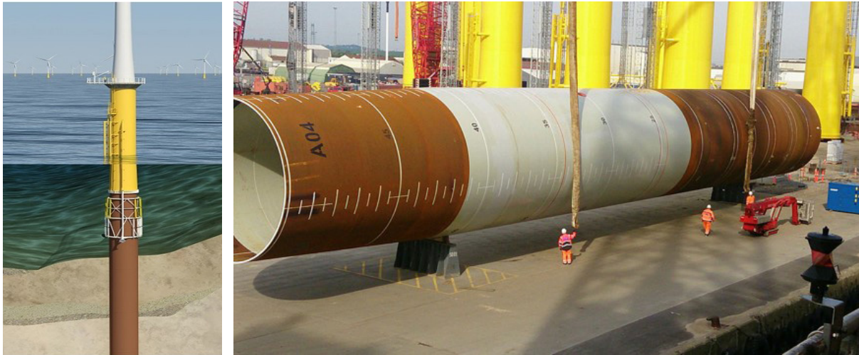
Figur 9 Till vänster: illustration av ett färdigt installerat monopilefundament. Till höger: tillverkning av monopilefundament. I bakgrunden syns färdiga övergångsstycken. Källa: COWI
