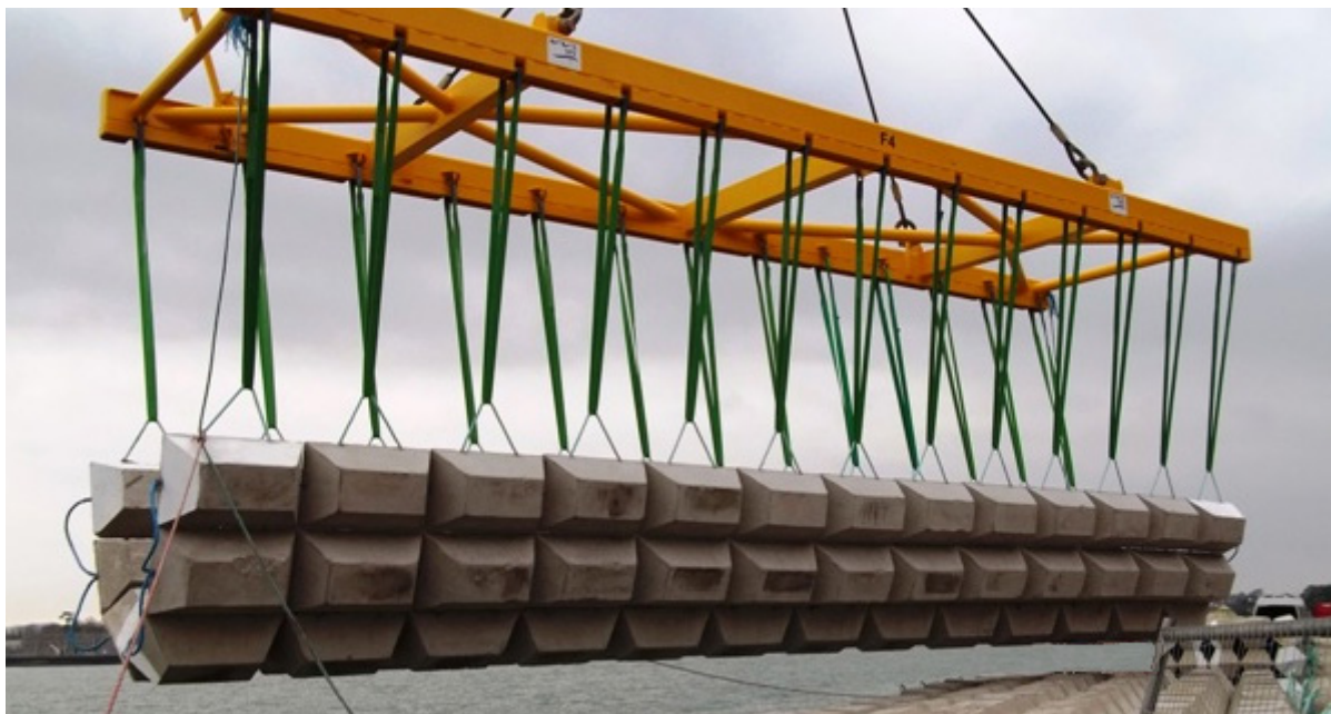
Figur 21. Exempel på betongmadrass som används som kabelskydd. (Källa: Subsea Protection Systems)
