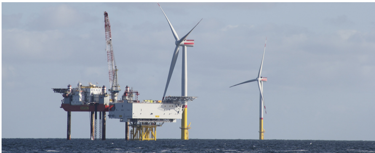
Figur 16. Jack-up fartyg vid en transformatorstation som är grundlagd på en fackverkskonstruktion.
