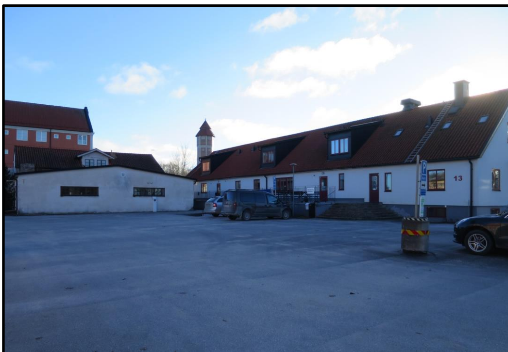
Hönsslakteriet, Järnvägen 5, till vänster och Packeriet/VIC-tvätten, Järnvägen 8, till höger. Ovanför Järnvägen 5 syns ett av den nyare bostadshusen på Järnvägen 6. Mitt i bilden syns övre delen av vattentornet, uppfört efter Anders Serbonis ritningar, 1925.
