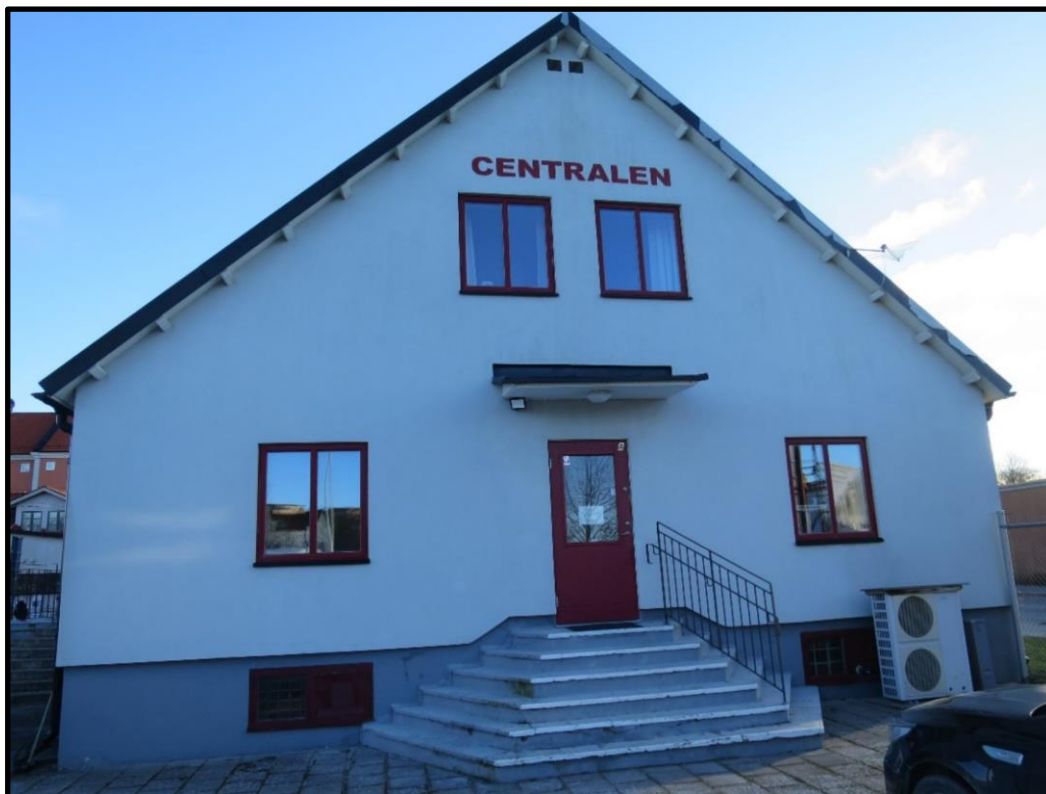
Gavelentrén mot sydväst, med ursprungligt skärmtak. Även fritrappan är ursprunglig, men har vid något tillfälle renoverats med pågjutning och målats.
