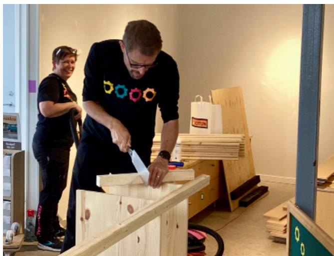
Delar av personalen bygger ny butik hösten 2024.
